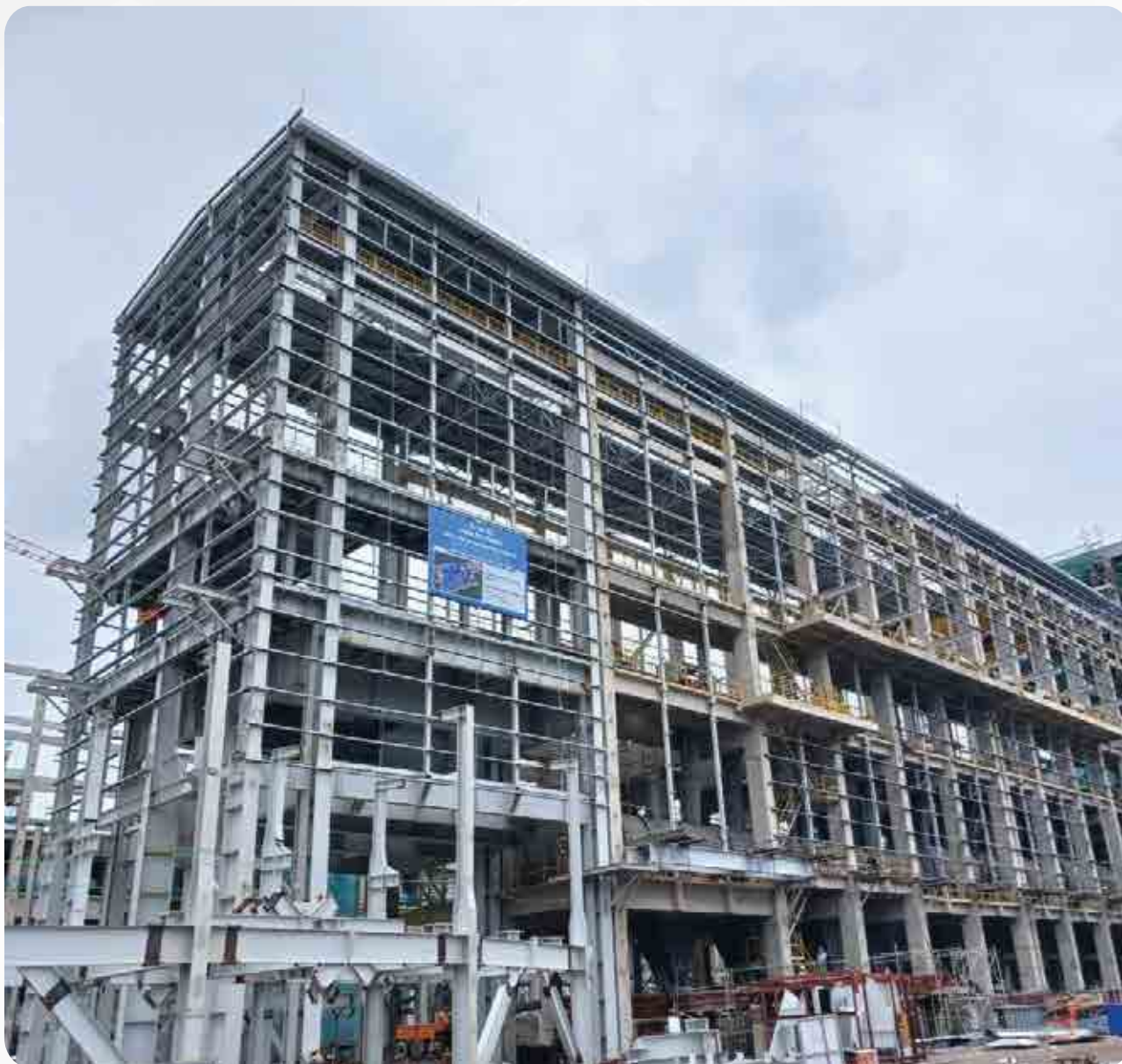
Kết cấu thép công trình xây dựng
