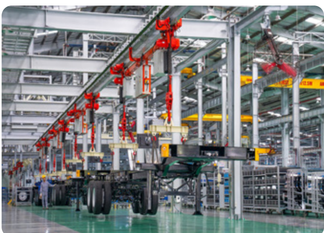
LẮP ĐẶT MÁY MÓC, THIẾT BỊ INSTALLATION OF MACHINERY AND EQUIPMENT
