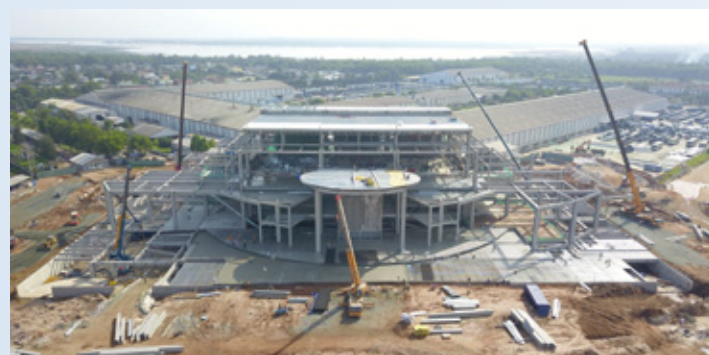
Kết cấu thép Tòa nhà điều hành THACO Chu Lai Steel structure of THACO Chu Lai executive building
