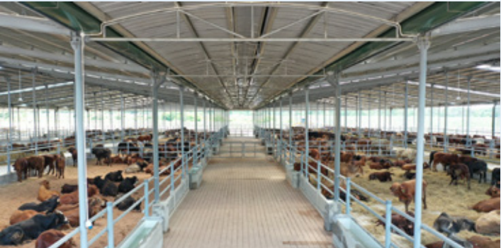
Kết cấu thép và hệ thống chuồng trại Steel structure and cow barn system
