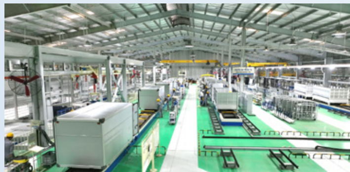
Kết cấu thép bên trong Trung tâm cơ khí Steel structure inside the Mechanical Center
