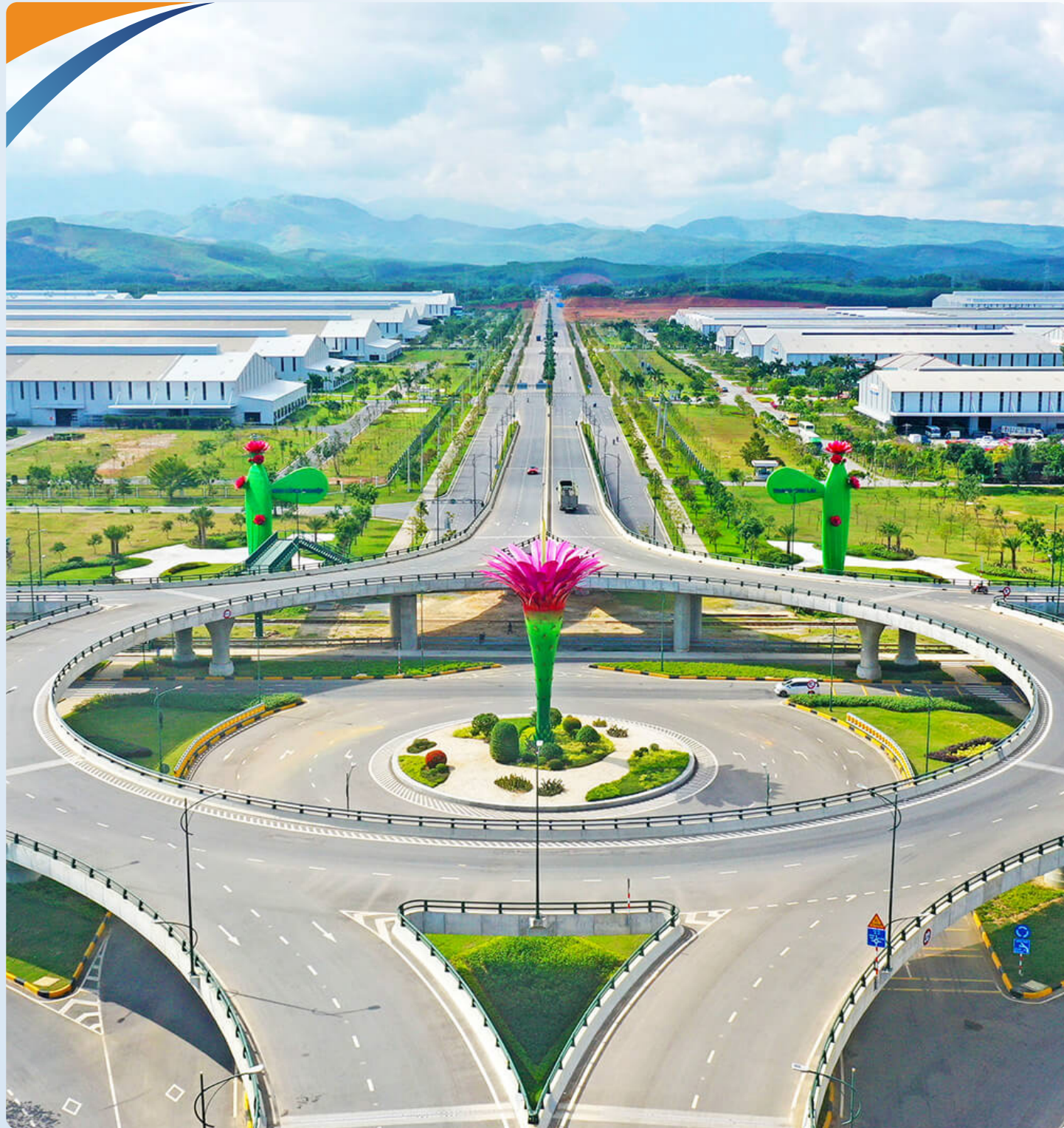
CẦU VƯỢT CHU LAI QUẢNG NAM | FLYOVER IN CHU LAI (QUANG NAM)
