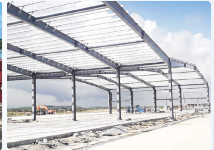
CÔNG TRÌNH NHÀ CHE MÁY BAY | HANGAR
