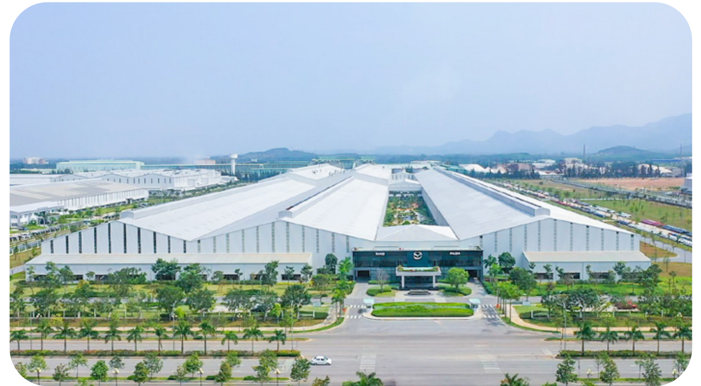
NHÀ MÁY SẢN XUẤT Ô TÔ MAZDA Vị trí: KCN THACO Chu Lai, huyện Núi Thành, tỉnh Quảng Nam Quy mô: 30,3 ha
