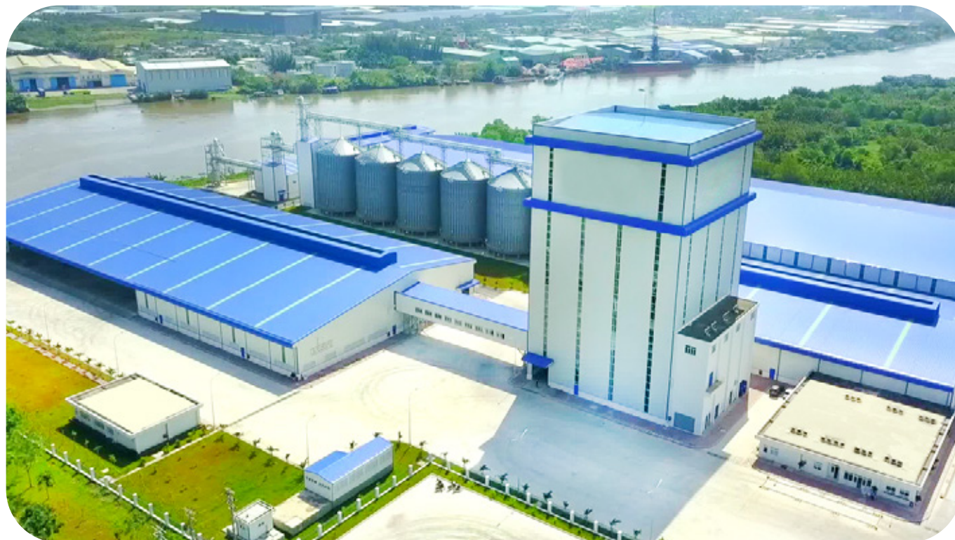
NHÀ MÁY THỨC ĂN - VIỆT THẮNG LONG AN Vị trí: KCN Nhựt Chánh, huyện Bến Lức, tỉnh Long An Quy mô: 7,6 ha
