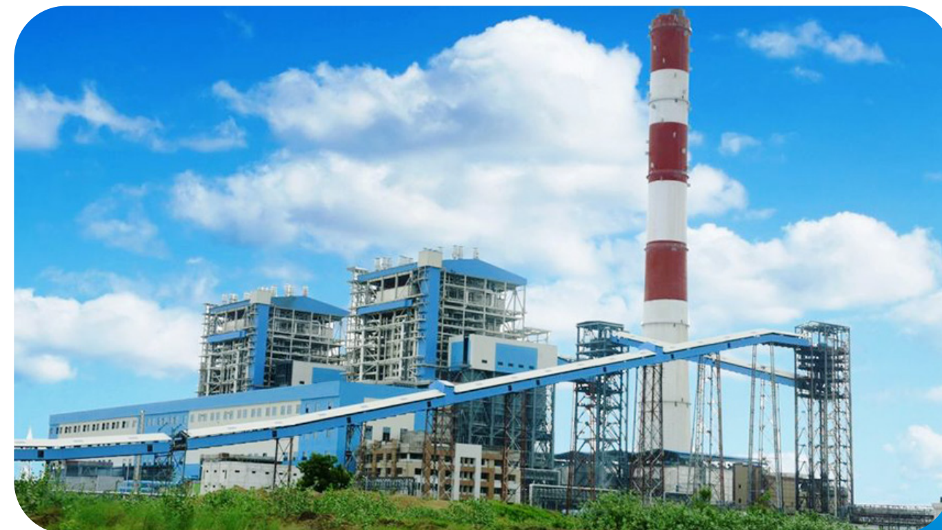
NHÀ MÁY NHIỆT ĐIỆN NGHI SƠN 2
