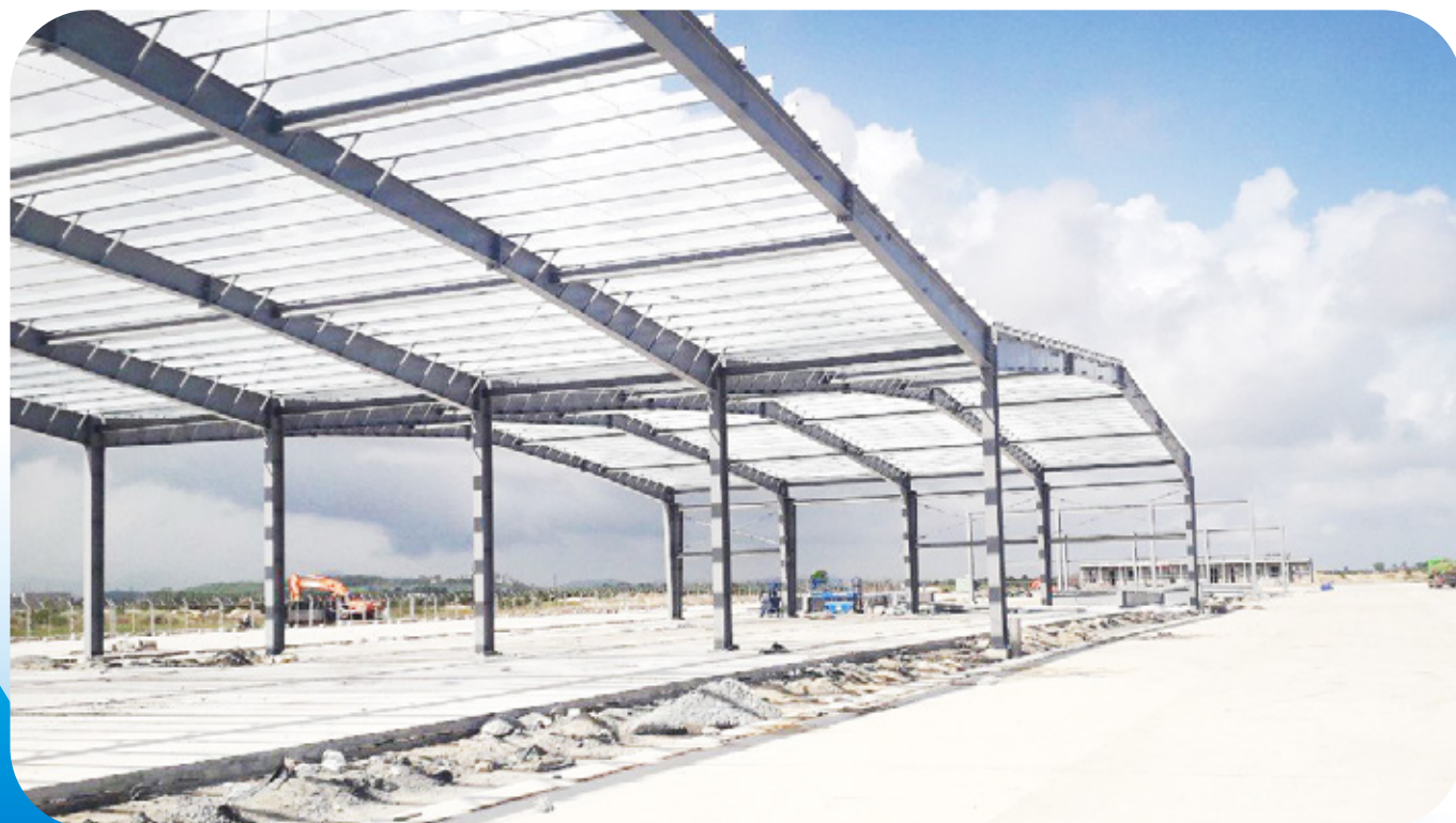
CÔNG TRÌNH NHÀ CHE MÁY BAY Vị trí: Sân bay Chu Lai, huyện Núi Thành, tỉnh Quảng Nam Hạng mục: Gia công 300 tấn kết cấu thép
