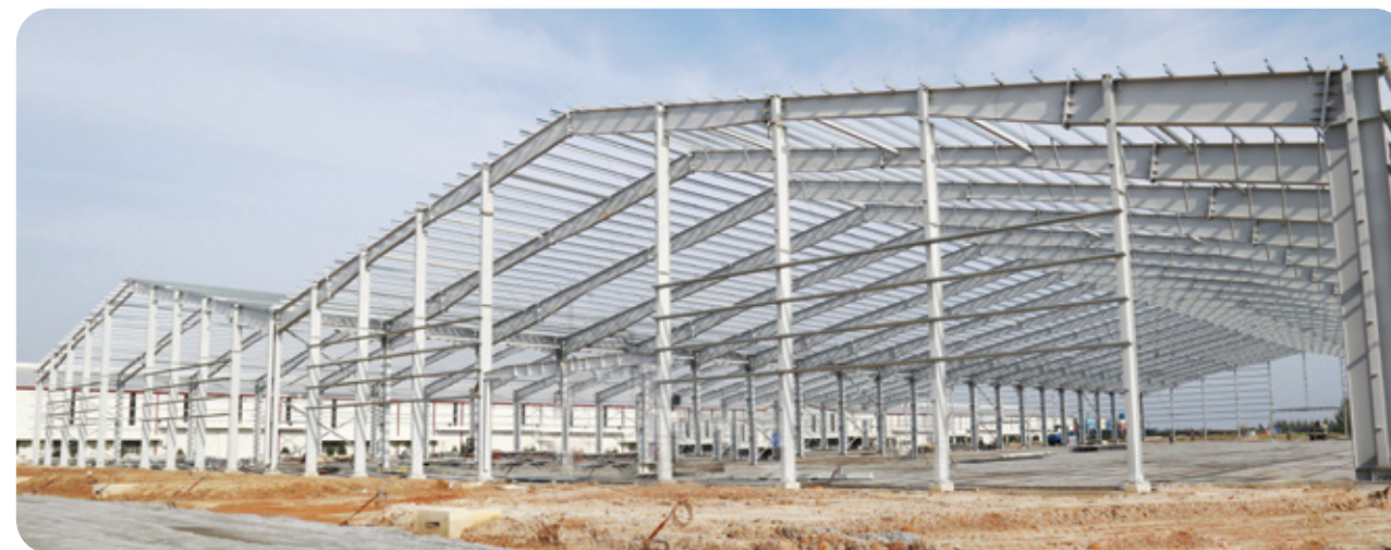
Thi công nhà thép tiền chế
