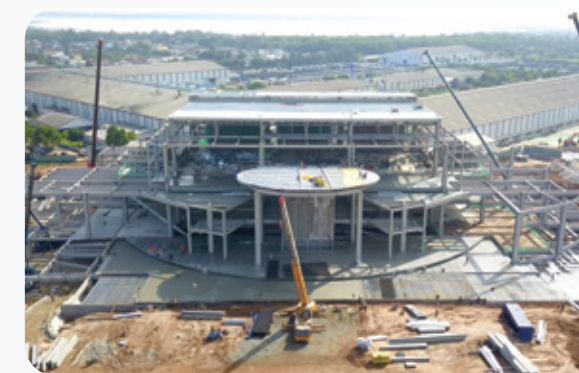
Lắp dựng công trình xây dựng
