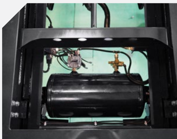
1 Lắp ráp hệ thống hơi
