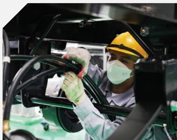
6 Kết nối hệ thống điện và hệ thống hơi
