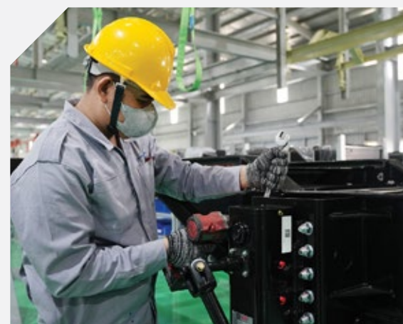
3 Lắp ráp chân chống
