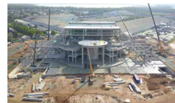
Lắp dựng công trình xây dựng Construction entity installation
