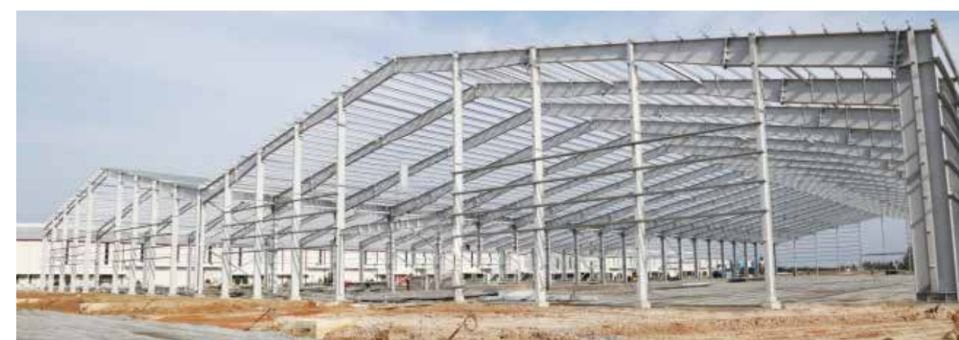
Thi công nhà thép tiền chế Pre-engineered steel building
