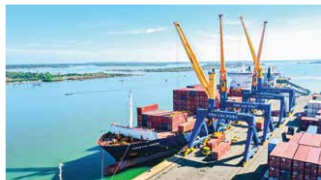
Chân đế cầu trục Crane base
