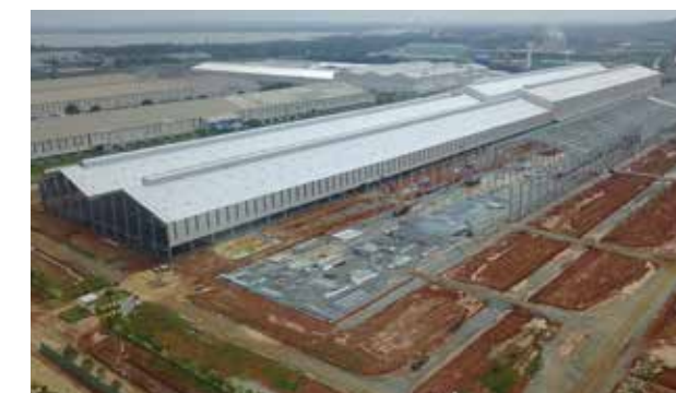
Lắp dựng nhà xưởng Workshop building installation
