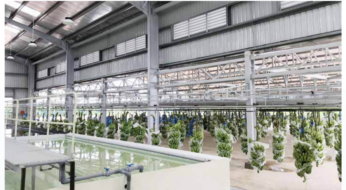
NHÀ XƯỞNG CHẾ BIẾN TRÁI CÂY
