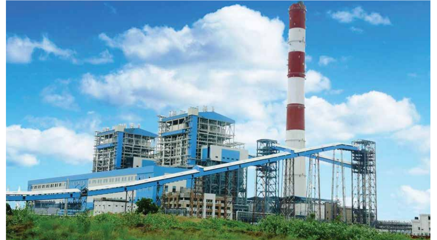
KẾT CẤU THÉP NHÀ MÁY NHIỆT ĐIỆN NGHI SƠN 2
