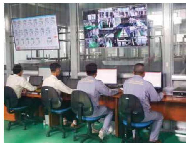
Phòng điều khiển trung tâm Control center room
